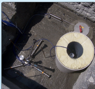
• Nid d'instruments dans le corps du barrage
