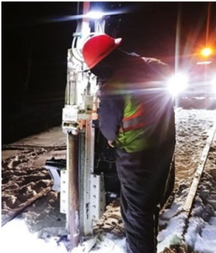
Forage avec la plate-forme Geoprobe
