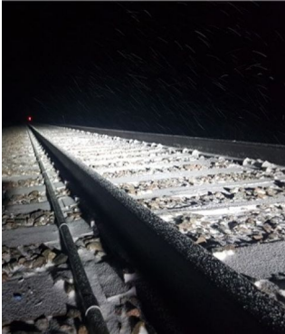
Section de la voie ferrée à Smith Falls
