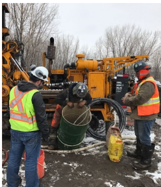
Préparation de l'injection du coulis de ciment
