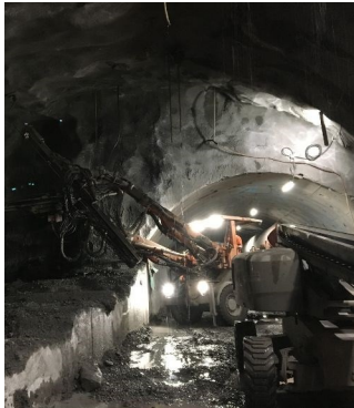
Installation des extensomètres simples dans le tunnel
