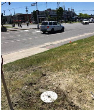
Monitoring en surface caché dans des boîtes de service
